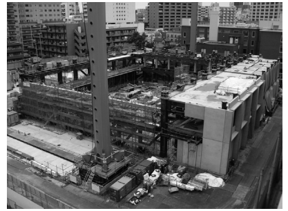
完成に向け工事進行中
